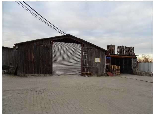
Abb. 7: Südfassade der Lagerhalle
