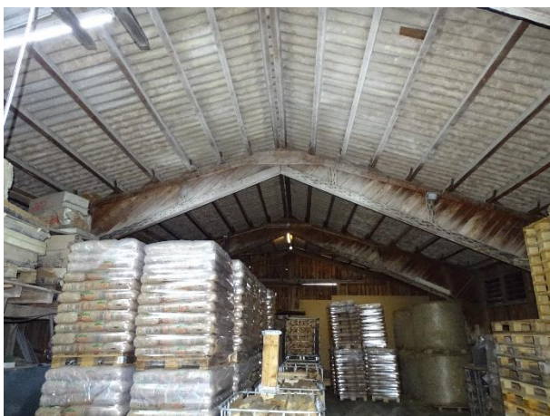
Abb. 8: Holzbalken der Dachkonstruktion der Lagerhalle
