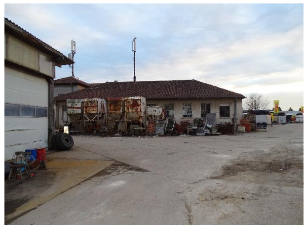
Abb. 3: Nordfassade der Werkshalle
