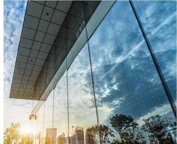
Abb. 28: Glasfassade mit Punktmuster, Quelle: SEEN AG
