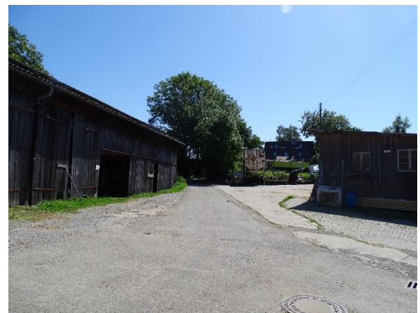
Abb. 8: Versiegelte Fläche auf Flst.-Nr. 20/1, Stall auf Flst.-Nr. 18/1 (links) und Schuppen auf Flst.-Nr. 19 (rechts)
